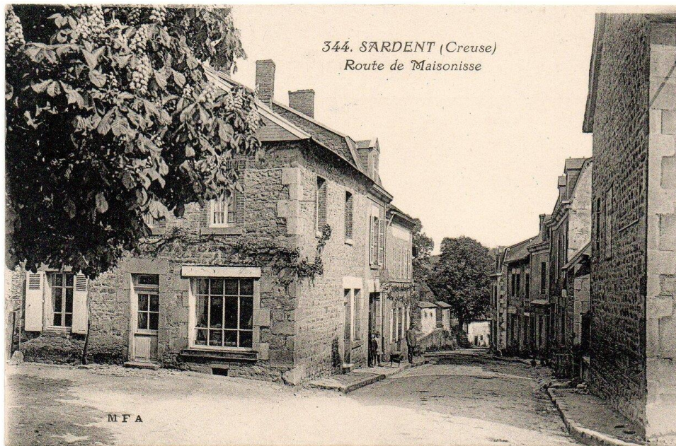
Exemple de bâtiment en maçonnerie limousine
